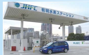
水素ステーション
